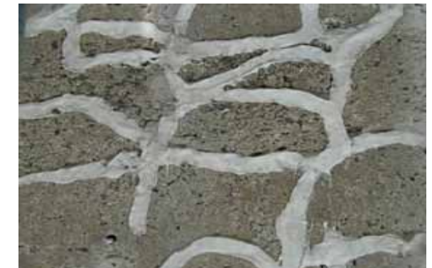
(f) ひび割れ部のシール状況(03/4/21)
