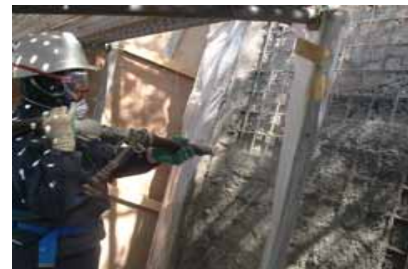
(g) 吹付け状況(03/4/21~23)
