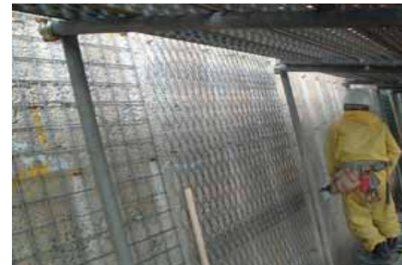
(e) 補強材設置状況(03/4/21)
