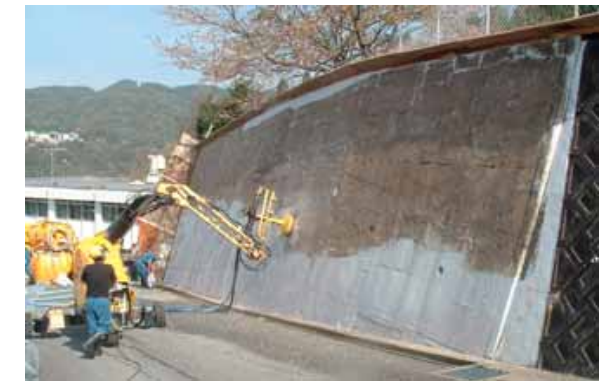
(b) ウォータージェット法による表面はつり(03/4/18)
